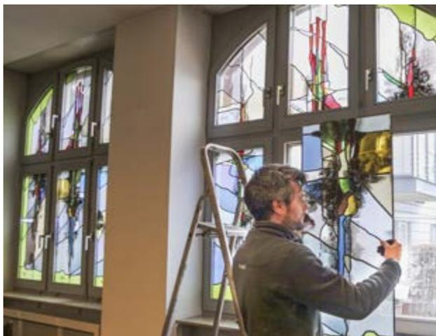
◀ In der Kapelle im historischen Altbau wurde die Bleiverglasung der sechs Rundbogenfenster ausgebaut. Jedes Fenster besteht aus sechs einzelnen Scheiben.
